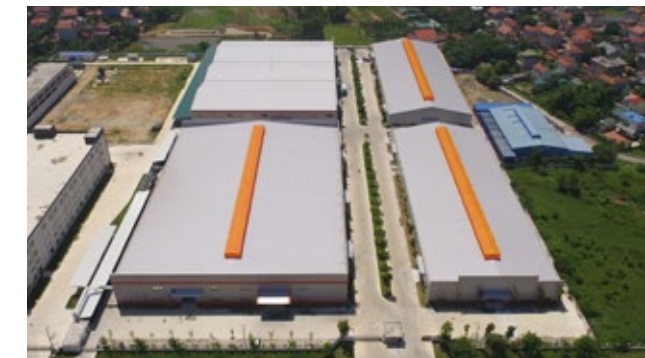
Nhà xưởng Khu công nghiệp Bình Xuyên
